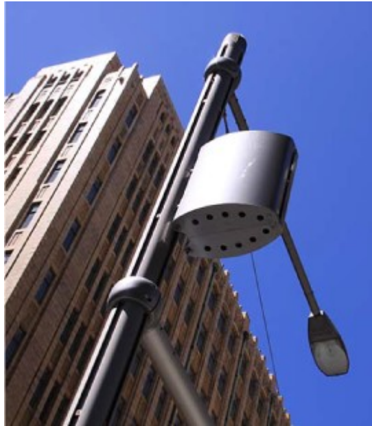
Εικόνα 3: Ένα microcell σε λάμπα δρόμου [6]
